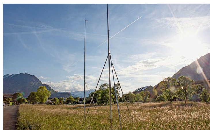
Bönigen, in den Gärten: Hier entstehen sieben Wohnhäuser mit insgesamt 82 Wohnungen. Die Profile stehen. Foto: Christoph Buchs
